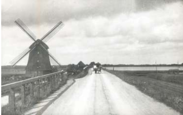
Afb. 1 Deze foto van de Zuiderdijk is gemaakt voor 1919 en nabij het gemaal van de Drieban genomen. Op de weg staat een hondenkar waarschijnlijk van de bakker. Voor de bouw van het stoomgemaal in 1919 stonden hier drie watermolens om de polder Hem/Venhuizen te bemalen. Het midden van de weg is verhard met stenen en de zijkanten bestaat uit schelpen, die door de wielen zijn kapot gereden.
